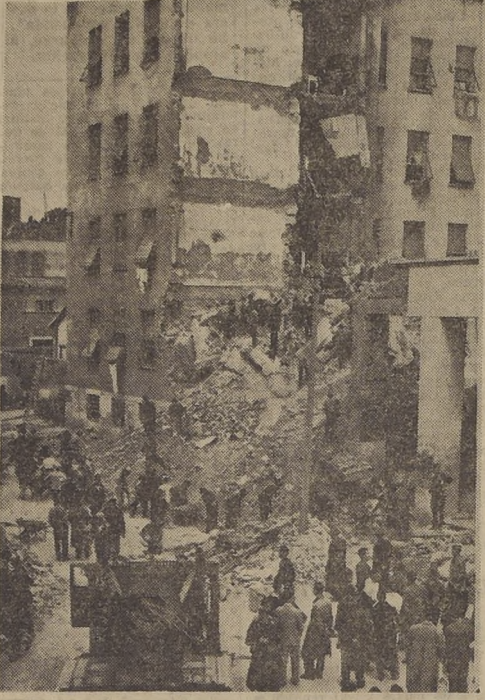
SE DERRUMBO EL EDIFICIO DE UN COLEGIO EN ITALIA.— Cuadrillas de obreros dan comienzo a la obra de limpiar de escombros la calle, después que el edificio del colegio "Giorgio Franceschi", ocupado por refugiados, se derrumbó solo. Murieron tres personas y 12 resultaron heridas.—El alcalde de Roma, Salvatore Rebecchini fué silbado y amenazado por una enfurecida muchedumbre cuando visitaba el lugar del desastre. (Foto ACME)
