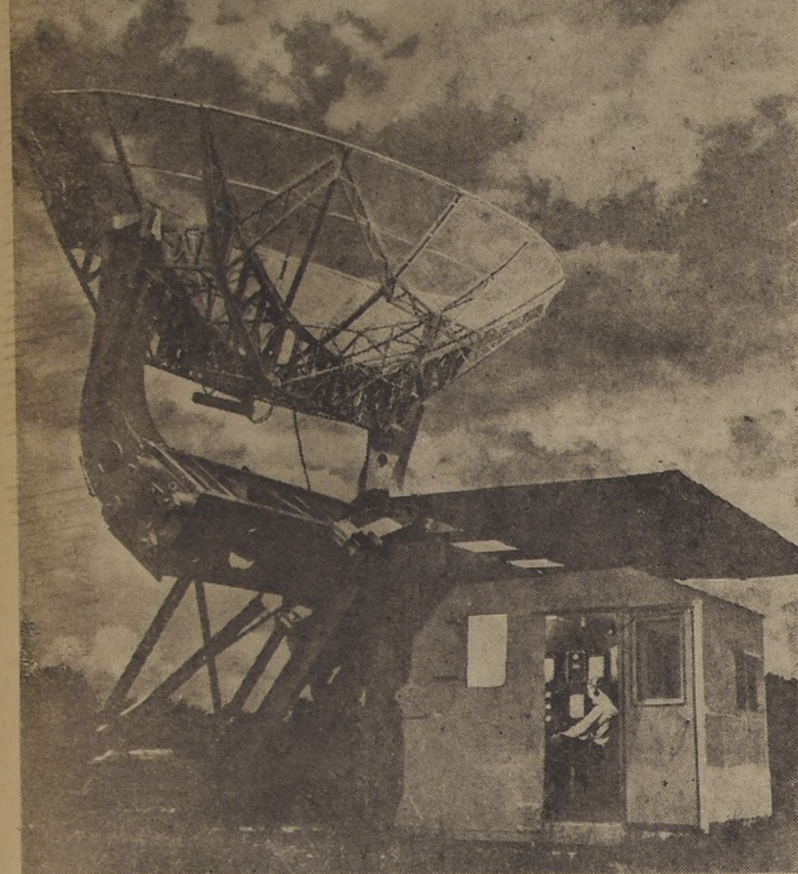
El telescopio radial de la Estación "Sterling" de los Estados Unidos, en Virginia, es un enorme espejo cóncavo, reflector que recibe las ondas radiales desde un pequeño espacio en el cielo. El observador se sienta en la cabina a la derecha. Los sonidos radiales que recibe, se transforman en un débil sonido siseante. La amplitud de la señal se marca en una cinta que pasa lentamente a través del aparato.
