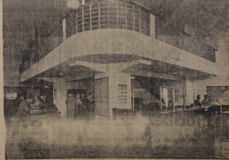
VISTA GENERAL DE LAS OFICINAS EN SANTIAGO
