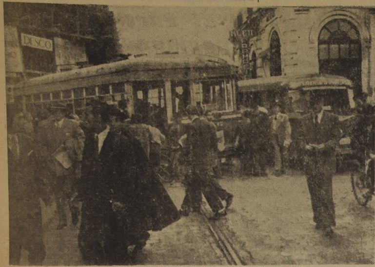
Así quedó el tranvía de la línea Lord Cochrane-Cementerio Católico, que se desvió en la tarde de ayer en Bandera esquina de Huérfanos. Al precipitarse sobre un edificio en construcción de la firma Desco, aprisionó contra la muralla a un transeúnte, dejándole gravemente herido. Una hora estuvo interrumpido el tránsito por este accidente.
