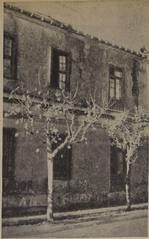
LICEO DE NIÑAS DE SAN BERNARDO.- Otro aspecto del edificio en que funciona el Liceo de Niñas de esta localidad y cuyas deficiencias constató personalmente el Intendente de la provincia, señor Jorge Rivera Vicuña...
