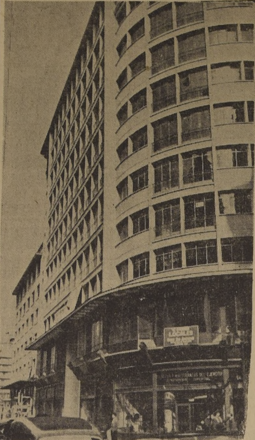
Aspecto del edificio de la Unión Española de Seguros
