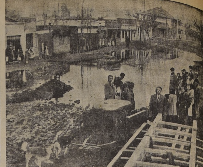
BOMBEROS ELIMINAN FOCOS INFECCIOSOS, EN QUINTA NORMAL. - Voluntarios de la Compañía de Bomberos de Quinta Normal, en una encomienda incluyente, están trabajando día y noche, en la limpieza de los enormes fangos que se formaron en las calles de esa comuna con motivo de las últimas lluvias. En el grabado, la bomba extractora de agua y vapor, en plena labor en la calle Blanco Garcés, donde, como lo muestra la fotografía, la vía está transitable, además de constituir estos estancamientos peligrosos focos de enfermedades. Dirigidas las faenas el capitán Raúl del Río, a quien secundan los voluntarios Víctor Indo, Sergio Cordero y Hugo Moreno.
