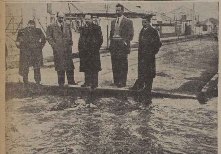
CANAL ABIERTO EN POBLACIÓN LOS LEONES-SUR. — La foto muestra el canal abierto que atraviesa la calle Rey Cristóbal X. de la comuna de Ñuñoa, y que constituye un peligro para los automobilistas desprevenidos y habitantes del sector, y, sobre todo, para los niños. El canal lleva toda clase de desperdicios, y cuando llueve mucho se desborda, haciendo difícil el acceso a la calle.
