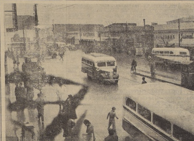
CRUCE QUE PROVOCA CONFLICTO DE AUTORIDADES.— La neurálgica y congestionada equina de San Diego con Franklin, donde la Municipalidad suprimió el paradero de microbuses, trasladándolo a Bio Bio. Este cambio ha causado profundo malestar en el comercio y el vecindario del populoso sector afectado. Su restablecimiento exigirá la Dirección General de Transporte y Tránsito Público, haciendo uso de las atribuciones legales de que está prevenida, y que ahora le han sido reconocidas por la Contraloría. Según la Municipalidad, ese servicio es ilegal y debe eliminarse.
