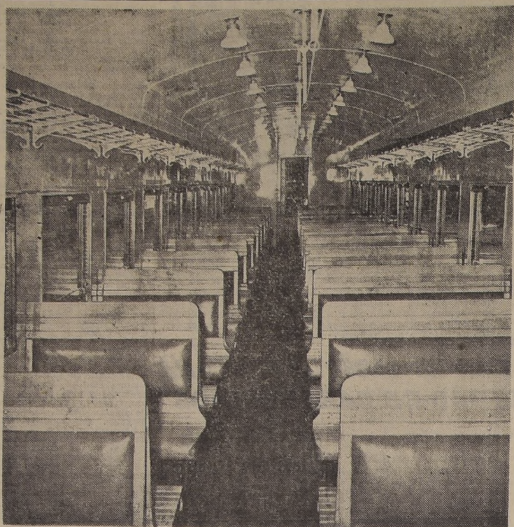
Detalle del interior del nuevo coche de acero para los Ferrocarriles del Estado, construido íntegramente en Chile, en los talleres de Socometal. La única diferencia con los coches de lujo en servicio actual, está en los asientos. La seguridad y construcción metálica son idénticas a los coches de primera
