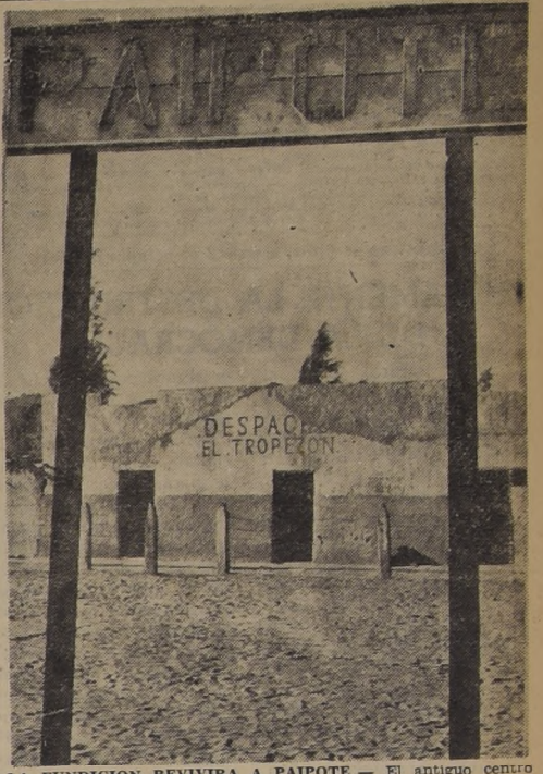
LA FUNDICION REVIVIRA A PAIPOTE. — El antiguo centro minero de Paipote, a 10 kilómetros al sur de Copiapó, y desde hace muchos años abandonado, revivirá con la Fundación Nacional que se ha instalado en él, para servir a los intereses de la pequeña minería. La Fundación encenderá oficialmente sus hornos en la segunda quincena de este mes y es, al lado de Huachipato, una de las grandes obras realizadas bajo el Gobierno del Excmo. señor Gabriel González Videla, en favor de la industrialización del país. La foto muestra el nombre del pueblo junto a la línea férrea, con el fondo de un despacho construido con adobe, parcialmente reparado. Esta foto pertenece a la Exposición de la "Fundación Nacional de Paipote", realizada por Marcos Chamudis, y que puede visitarse diariamente en su Sala, departamento 1000 del nuevo edificio del Progreso Urbano (Ahumada frente al Waldorf).
