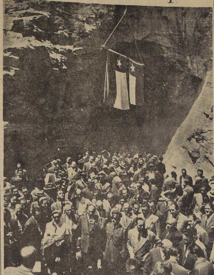
UNEN LAS GALERIAS DEL TUNEL.— El ministro de Obras Públicas, don Ernesto Merino Segura; autoridades y público que asistió a la ceremonia de la unión de las galerías del túnel en la cuesta de Lo Zapata, instantes después de haberse disparado el tiro de dinamita que rompió el muro divisor. Todos los oradores destacaron la importancia que esta obra tendrá para las comunicaciones entre Santiago y Valparaíso.
