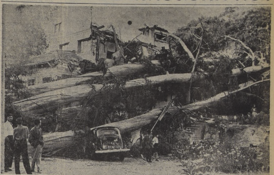
CHALET DESTRUIDO POR EUCALIPTUS GIGANTE.— Aspecto captado por LA NACION, que revela en toda su magnitud las consecuencias que tuvo para la residencia del señor Angel Haye Nahal y su automóvil Ford, modelo 1940, el violento temporal de viento que se desató en la tarde del viernes y que derribó un gigantesco eucalipto, de más o menos 40 metros de altura y de enorme grosor, que partió virtualmente en dos el chalet ubicado en la Población San Roque, en el antiguo barrio "Las Zorras" hoy "Bernardo O'Higgins" de Valparaíso. Afortunadamente este suceso no causó desgracias personales.
