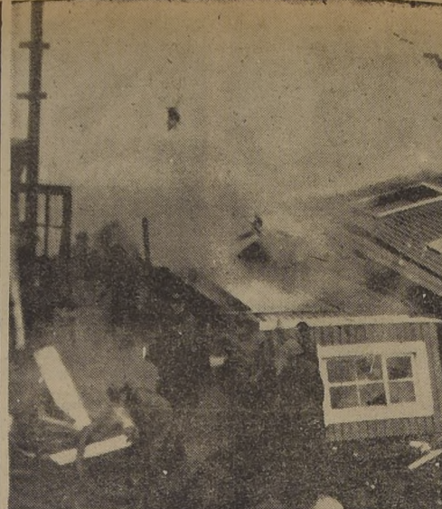
LA CASA QUEDO PARTIDA EN DOS Y HUBO 28 MUERTOS.— ELIZABETH Nueva Jersey.— Bomberos y policías y cuadrillas civiles de salvamento remueven los escombros de una casa que demolió un avión de la American Airlines, el estrellarse, el 22 de junio, en medio de un temporal de agua y nieve. En esta catástrofe murieron las 23 personas que iban en el avión y cinco ocupantes de los edificios tocados por la máquina, y en los que se inició un incendio. — (Foto United Press).
