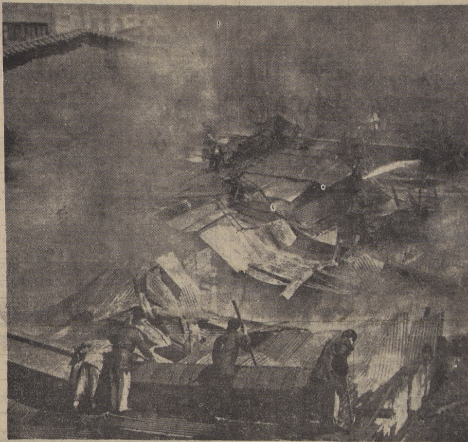
CUATRO GALLINAS CAUSARON ESTE SINIESTRO.— La fotografía muestra en toda su magnitud el siniestro de la mañana de ayer en Merced, donde cuatro gallinas que volcaron un brasero provocaron daños evaluados en 3 millones de pesos. El material ligero y antiguo del edificio, fue fácil presa para las llamas, viéndose muy dificultada la labor de los bomberos por lo encerrado de las llamas, que formaron densas humaredas.
