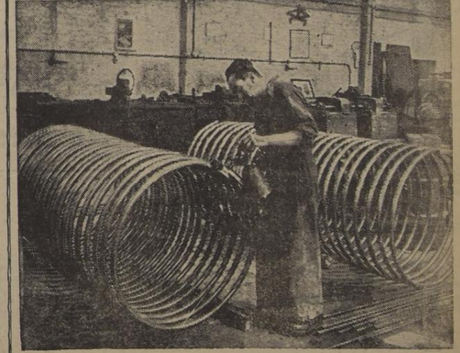
para serpentines industriales, serpentines de calefacción y condensadores; para instalaciones sanitarias y de calefacción en edificios.
