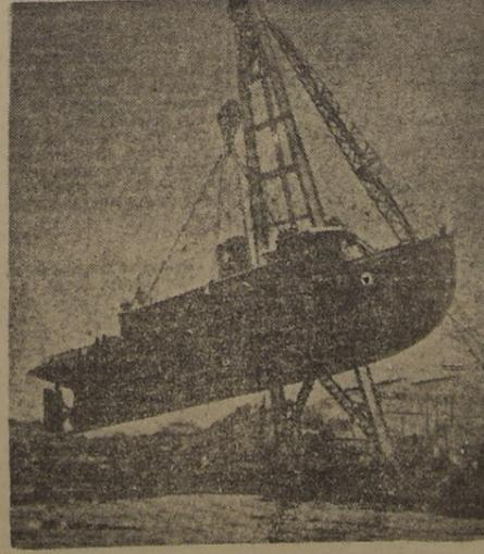
Una nueva técnica para el lanzamiento de barcos fué ensayada con éxito en Houston, Texas. Este barco de 150 toneladas fué izado por medio de una grúa gigante y descendido con lentitud hasta dejarlo a flote. — ("The Sphere", Londres).
