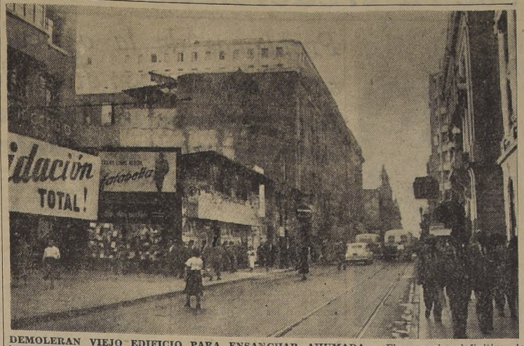
DEMOLERAN VIEJO EDIFICIO PARA ENSANCHAR AHUMADA. — El ensanche definitivo de la calle Ahumada comenzará el 5 de marzo próximo, inmediatamente después que la Municipalidad mantenga los recursos extraordinarios para esta obra de capital importancia para el descongestión de las vías céntricas. El edificio que muestra el grabado, y que forma esquina con Huérfanos, deberá ser demolido dentro de un plazo de treinta días, de acuerdo con la notificación del Alcalde. Es el único obstáculo para dar comienzo a los trabajos de ensanche.
