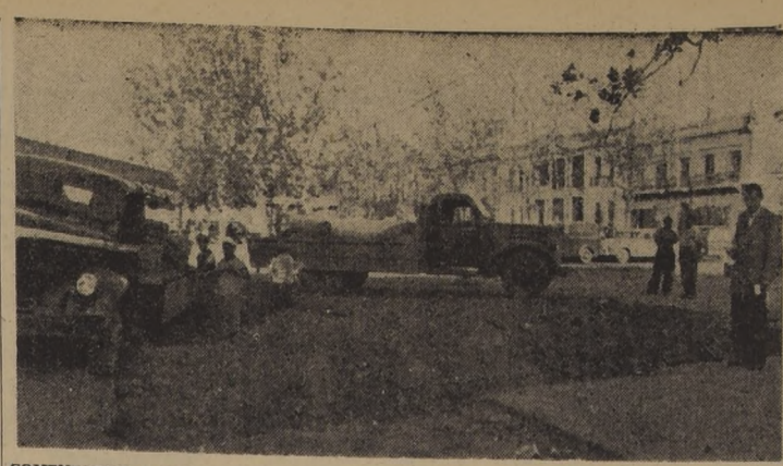
COMENZARON A TRANSFORMAR LA ALAMEDA. — Se iniciaron ayer los trabajos de transformación de la Alameda, en el sector comprendido entre Estado y Morandé. La reposición de las veredas, calzadas y jardines, que había sido convertida en un garaje público, en el que los automóviles destruyeron todo. En el grabado, obreros y material rodante del Departamento de Aseo y Jardines, en plena labor. Estas obras costarán 800 mil pesos.
