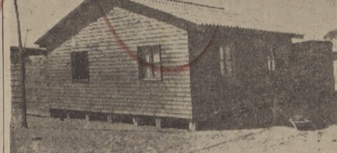
Una de las casas para el personal, en el recinto del Club Hípico de Peñuelas.
