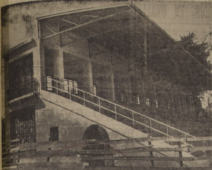
Modernas tribunas, recién construídas en el Club Hípico de Peñuelas.
