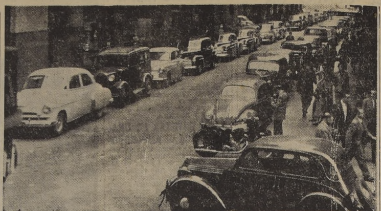
SIGUE AHOGADA POR ESTACIONAMIENTOS. — La calle Matías Cousiño, que ha sido proyectada exclusivamente para peatones, no sirve actualmente ni para éstos ni para vehículos...
