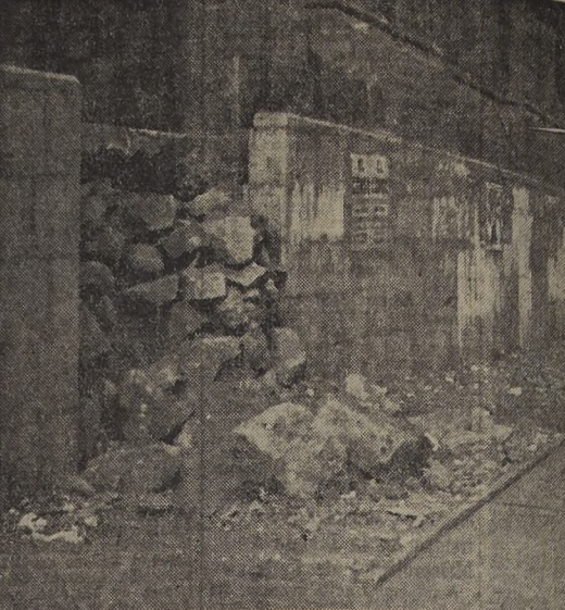
ESCOMBROS EN LA PUERTA CIEGA DE LA CATEDRAL.— Hace más de un año y medio las gestiones, fué autorizado el Venerable Cabildo Metropolitano para reparar la puerta ciega de la Catedral. Pero a causa de la falta de presupuesto, se ha dejado de reparar. Nade se ha hecho, pese a que el ensanche de Catedral, se ha hecho con rapidez. El Cabildo recibió once millones de pesos, para la extracción. Entraron, a seguir obstruida por piedras, que dan un desagradable aspecto a esta esquina.
