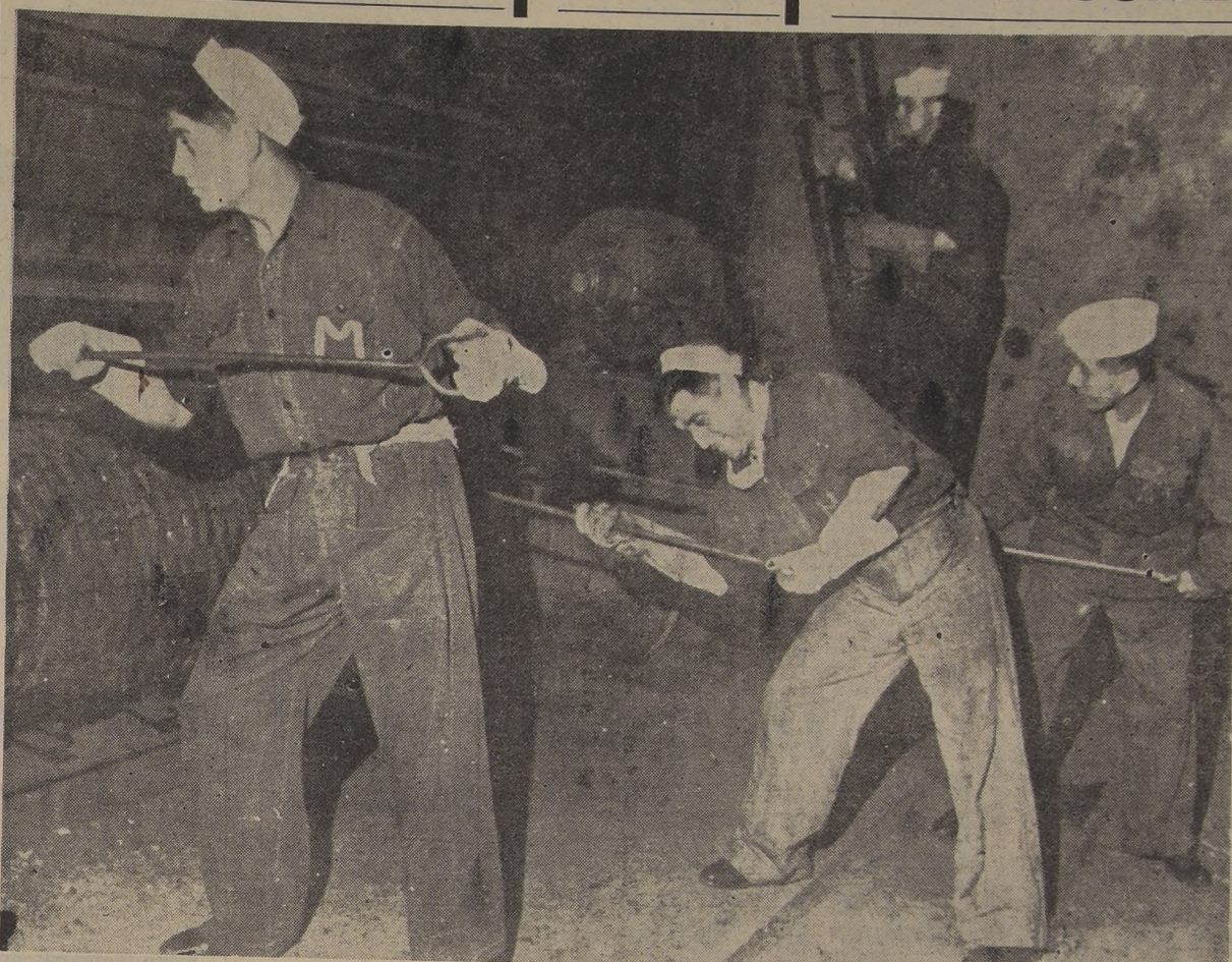
EN LA PLANTA ELECTRICA DE MAPOCHO. — Los cabos Juan Salazar, Osvaldo González, Héctor Guerrero y Héctor Muñoz, de izquierda a derecha, mientras trabajaban ayer en la Planta de Mapocho de la Compañía Chilena de Electricidad, Sesenta hombres de la Armada, especializados en estas faenas, llegaron en la madrugada de ayer desde Valparaíso, y gracias a ellos la capital contó con energía eléctrica para la industria y el alumbrado público y particular, con sólo ligeras alteraciones. En la tarde llegaron otros 90 hombres de marinería para reforzar las plantas.
