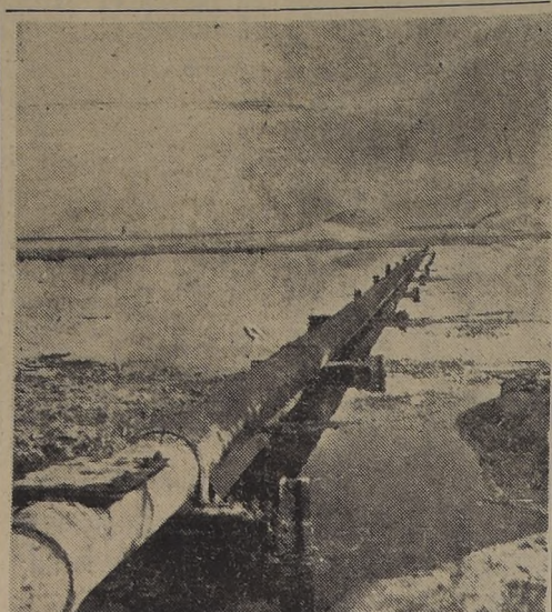
EL CAUSANTE DE LA POSIBLE CLAUSURA DE CARTAGENA.—El colector de aguas servidas de Cartagena, cuyo mal estado ha convertido a ese balneario en un foco de contagio hasta el punto que lleva las aguas servidas del pueblo hacia el mar, y en caso que no se realice, clausurar indefinidamente el balneario.
