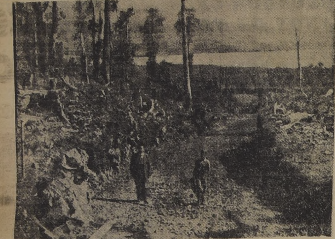
CAMINO AL VOLCAN OSORNO. Con gran actividad avanzan los trabajos del camino que unirá la localidad de Ensenada con el Volcán Osorno...
