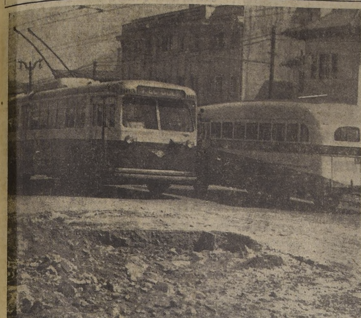
NO AVANZAN TRABAJOS DE PAVIMENTACION EN PROVIDENCIA.— A paso de tortuga se realizan los trabajos de pavimentación en Providencia. En el grabado, el cruce con Lyon indica la lentitud con que las autoridades de Pavimentación efectúan la reposición de la calzada. Troleobuses, buses y toda suerte de vehículos que circulan por ese congestionado sector, deben sortear las enormes zanjas abiertas, las que durante los días lluviosos fueron profundas lagunas.
