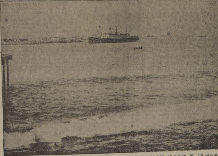
PELIGRO SU EXISTENCIA. — El incesante avance de arena y ripio por las aguas del río Maipo, está creando un grave problema al puerto de San Antonio, por el embancamiento de la mejor bahía de la zona central y la puerta de entrada de todos los productos y materiales para la industria del país, que está amenazado de hacerse insubstancial, de continuar la indiferencia de los poderes públicos.
