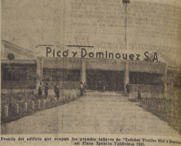
Frontis del edificio que ocupan los grandes talleres de "Teñidos Textiles Píco y Domínguez S. A." en Plaza Ignacio Valdivieso 2405.
