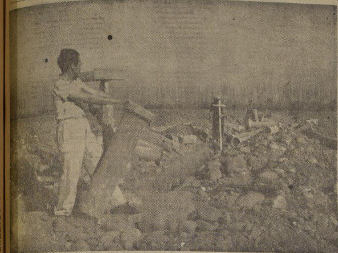
Intensamente se trabaja en la terminación de los tramos finales del alcantarillado, obra básica para la higiene y salubridad de la Población "La Castrina"
