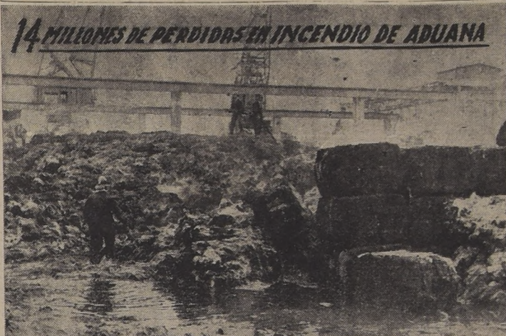
INCENDIO EN LA ADUANA. — Más de 14 millones de pesos de pérdida habría producido el incendio que en la mañana de ayer consumió una gran partida de mercaderías en la Aduana de Valparaíso. En las fotografías de arriba, los bomberos combaten los restos del fuego, entre los humeantes fardos de yute, corcho y celulosa.
