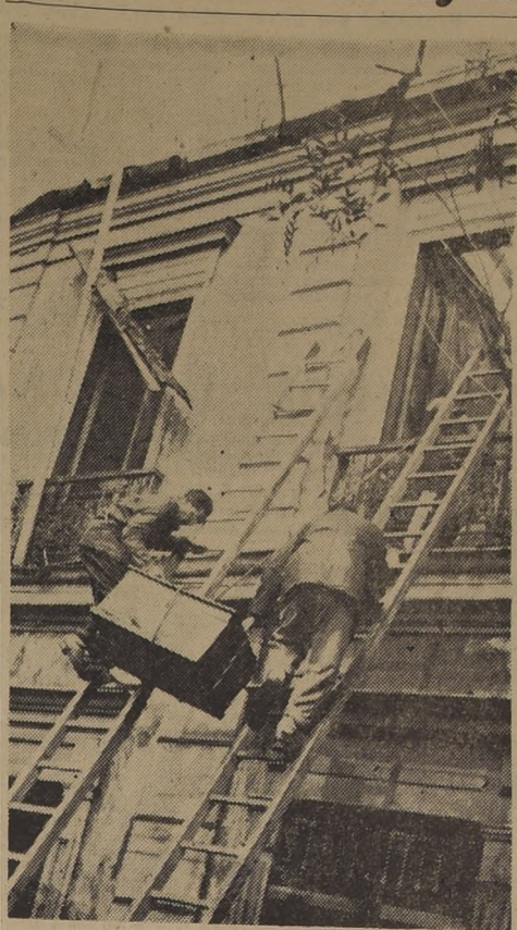
LABOR DE SALVAMENTO.— Una vez sofocado el fuego que destruyó ayer la casa de Vergara 177, y que produjo graves daños en las viviendas contiguas, dos voluntarios del Cuerpo de Bomberos suben con visible esfuerzo una caja con elementos de salvamento. Aparecen sin cascos ni uniforme de bombero, debido a que el llamado de la sirena exige que estos abnegados voluntarios ni siquiera piensen en su seguridad personal cuando la vida y los bienes de la colectividad se hallan en peligro.
