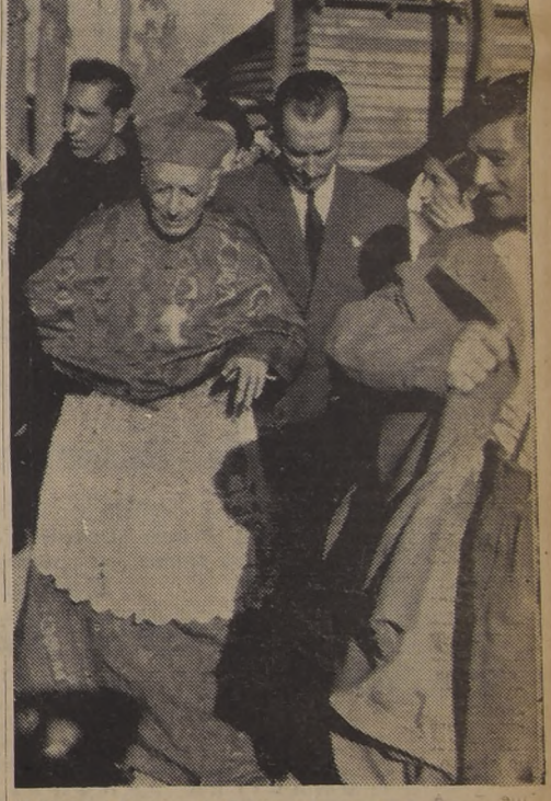
El Cardenal Arzobispo de Santiago, doctor don José María Caro, llega al sitio de las obras de la Empresa Municipal de Agua Potable de La Granja, para proceder a su bendición.
