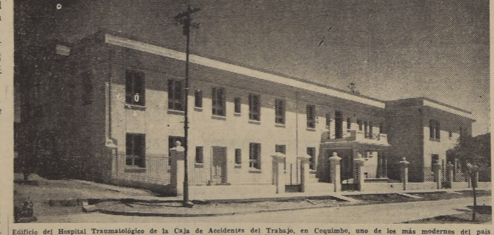
Edificio del Hospital Traumatológico de la Caja de Accidentes del Trabajo, en Coquimbo, uno de los más modernos del país en su especialidad
