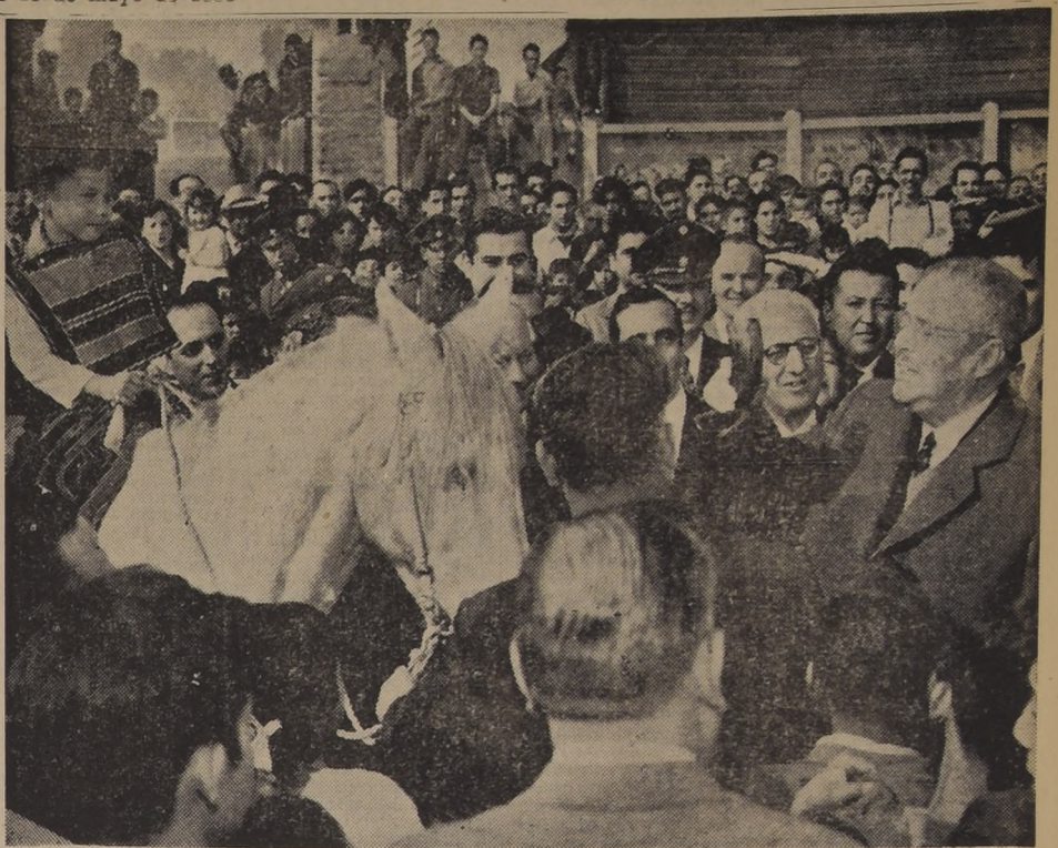
EL JEFE DEL ESTADO RECIBIO AYER EL HOMENAJE DE LA POBLACION. — El monolito recordatorio de una obra de enorme significación construida por el anterior administración del General don Carlos Ibáñez del Campo, el camino pavimentado de Santiago a Valparaiso fue inaugurado ayer. La ceremonia sirvió para que la población de Buzeta testimoniará el sincero afecto y la confianza inalterable que mantiene en el Jefe del Estado y en el programa de realizaciones de su Gobierno. S. E. recibió el aplauso de los pobladores, conversó con ellos y se manifestó complacido de las demostraciones de afecto que recibió. El clásico cacho de chicha que se brindó al Presidente de la República, enmarcó de auténtica chilendidad esta fiesta de ayer.
