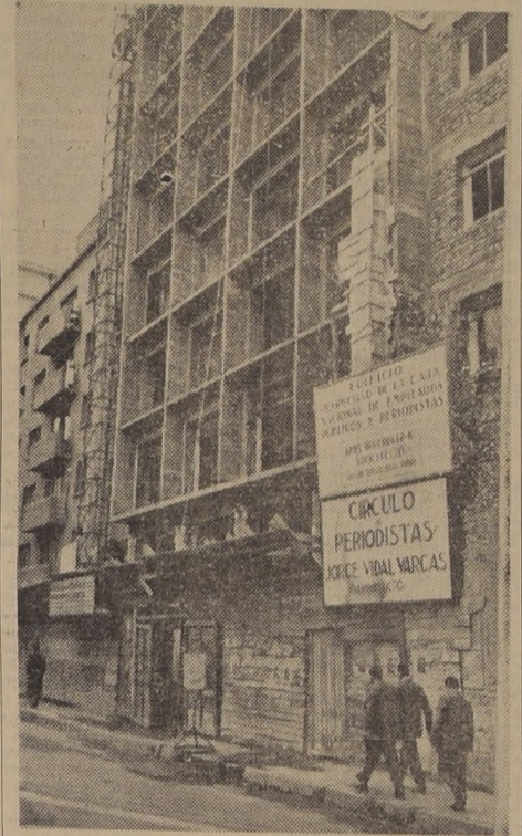
CASA DEL PERIODISTA QUEDARA TERMINADA EN DIEZ.— Con ritmo acelerado continúan los trabajos de construcción de la Casa del Periodista, ubicada en la calle Amunátegui, al llegar a la Alameda Bernardo O'Higgins...
