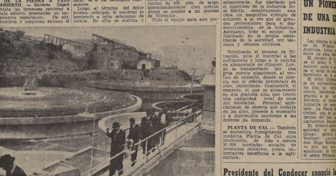
La comitiva inspecciona los estanques espesadores y de mezcla.
