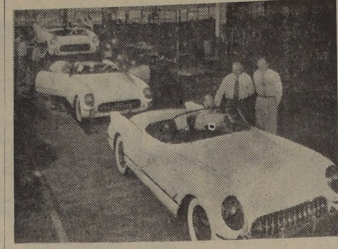
FLINT. — El primer automóvil con carrocería totalmente de material plástico sale de la línea de montaje en la planta Chevrolet. Este coche que se llama "corvette", tendrá un valor de venta de 3.250 dólares. (FOTO UNITED PRESS).
