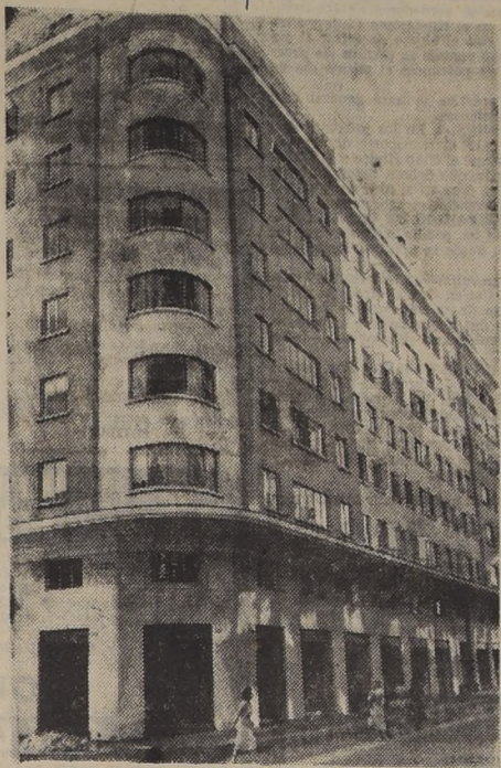
Fachada del edificio de la Caja de Empleados Públicos y Privados, que fue terminado en el año 1951.
