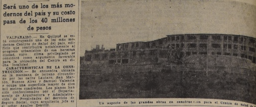
Un aspecto de las grandes obras en construcción para el Centro de salud de Valparaíso
