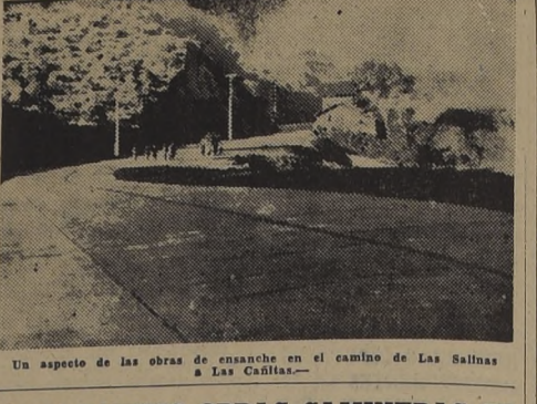
Un aspecto de las obras de ensanche en el camino de Las Salinas a Las Cañitas.
