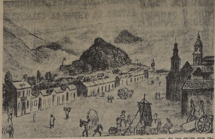
SERA HOY UNA GRAN ARTERIA. — La Avenida Bernardo O'Higgins, una de las calles que registra el mayor movimiento de vehículos y peatones, está siendo convertida en una gran arteria que permitirá que el tránsito se desplace con mayor rapidez. Las obras ya se iniciaron y ellas corresponden al sector comprendido entre las calles Mac Iver y Morandé; trabajos que darán a la Avenida Bernardo O'Higgins una moderna fisonomía. El grabado nos muestra un aspecto de esta avenida, cuando era conocida como "La Cañada" en los días de la Colonia, pudiendo advertirse en el primer plano la maciza estructura del templo de San Francisco.
