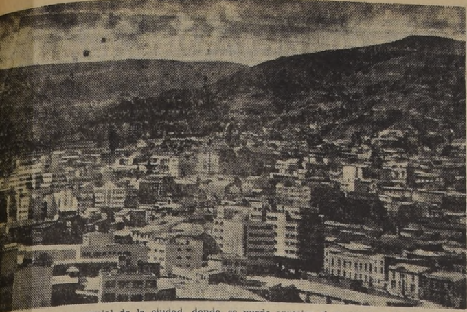
PAZ.— Barrio comercial de la ciudad, donde se puede apreciar el progreso en la construcción de edificios modernos.
