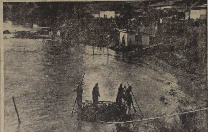
TRANSPORTAN PUENTE DESARMABLE.— Conscriptos de la Escuela de Ingenieros Militares de Tejas Verdes, al mando del mayor don Enrique Eber, en una balsa neumática, conectada a cables de acero, transporta por el río Maipo, cerca de su desembocadura en San Antonio, las partes esenciales de la estructura de un puente metálico, que será armado hoy sobre el camino longitudinal, en el tramo Rosario-Rengo. Con esta obra se normalizará el tráfico carretero al sur del país.
