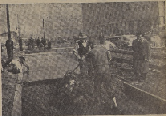
PAVIMENTACION EN LA ALAMEDA. — Se activan los trabajos de pavimentación y repavimentación que la Municipalidad de Santiago está efectuando en diversos tramos de calles céntricas de la capital, con el objeto de ampliar el ancho de las calzadas y permitir el mejor desarrollo del intenso tránsito metropolitano. El grabado correponde a los trabajos que se realizan en la Avenida Bernardo O'Higgins, entre Bandera y Morandé. Como se puede advertir, el retiro de los rieles de los tranvías, que luego en su totalidad no correrán por las calles del moderno Santiago, ayudará a disponer de mayor espacio para la expedición del tránsito público.
