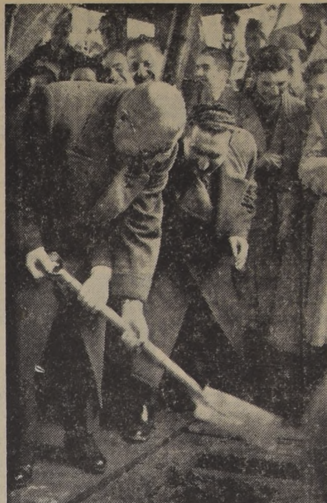
COLOCACION DE LA PRIMERA PIEDRA DEL NUEVO EDIFICIO DE LA ESCUELA DE MEDICINA VETERINARIA. — S. E. el Presidente de la República, echa una palada de tierra a la piedra simbólica que contiene el documento firmado por el Primer Mandatario, los Ministros de Minas y de Agricultura y otras autoridades, en el recinto en que se construirá la Escuela de Medicina Veterinaria. Junto al Primer Mandatario aparece el Ministro de Agricultura, señor Alejandro Hales, y alumnos
