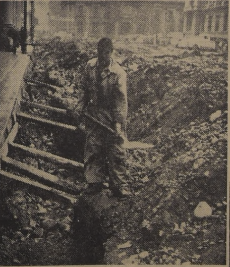
EL UNICO TRABAJADOR.— Oscar Garrido, de 34 años de edad, es el único operario de la Compañía de Consumidores de Gas de Santiago que ayer martes 22, a las 16 horas, se encontraba trabajando en el sector comprendido entre las calles Bandera y Morandé, en la colocación, empalme y traslado de las redes subterráneas que es necesario completar para iniciar los trabajos de pavimentación de la calle Compañía. Esta foto es un documento gráfico irrefragable de la inexplicable lentitud con que las compañías de servicios públicos y la Dirección de Pavimentación de Santiago se han abocado a las obras proyectadas en esta importante arteria.
