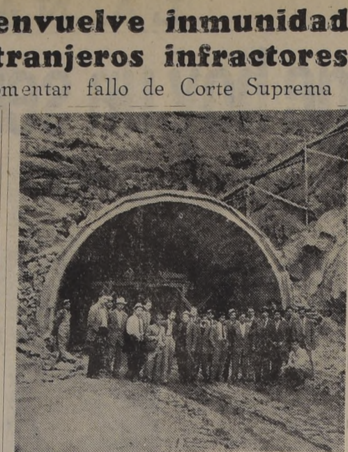
VISITA AL TUNEL DE ZAPATA. — Alumnos de Ingeniería de Técnica del Estado, acompañados del ingeniero de la Dirección de Vialidad, señor Julio Echevarría A., visitaron recientemente el Túnel de Zapata, en el Km. 89 del camino de Santiago a Valparaíso.
