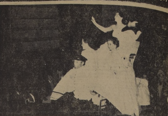
BODAS DE PLATA DE LA UNIVERSIDAD CATOLICA. - La muchachada de la Universidad Católica está contenta con gran entusiasmo los 25 años de existencia que al servicio de la cultura ha cumplido este plantel de estudios, el día de hoy, en el edificio de toda la ciudad. La Universidad Católica de Valparaíso, que atiende la situación económica de las familias de Chile, se sirva considerarlo como una colaboración a las autoridades de la provincia por aliviar la triste situación económica de esas personas. El pan entregado por el señor Espinal alcanzó a más de mil familias. El intendente agradeció este gesto de solidaridad social en una concisa nota.
