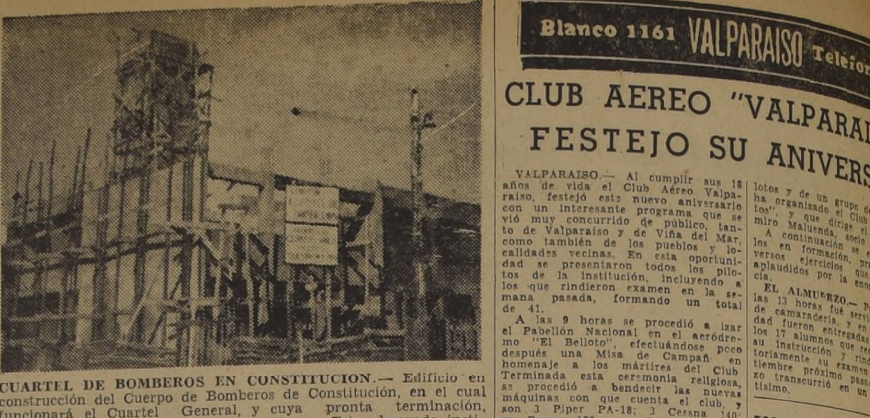
CUARTEL DE BOMBEROS EN CONSTITUCION. Edificio en construcción del Cuerpo de Bomberos de Constitución...
