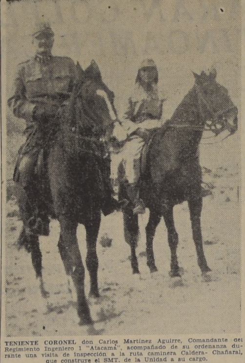
TENIENTE CORONEL don Carlos Martínez Aguirre, Comandante del Regimiento de Ingenieros No 1 "Atacama", acompañado de su ordenanza durante una visita de inspección a la ruta caminera Caldera-Chañaral, que construye el SMT. de la Unidad a su cargo.
