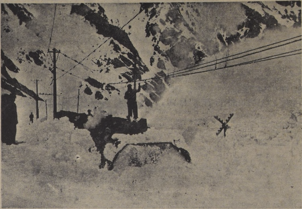
ROMPEN EL CERCO DE NIEVE.— Un 'rotatorio' Garret, a vapor, alanzado por tres locomotoras que trabajan andino, a 200 metros de la Estación de Caracoles. Los rodados y las intensas nevadas que azotaron a este sector cordillero...
